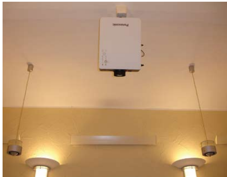
Короткофокусный проектор Panasonic закреплен на потолке в вертикальном положении.
